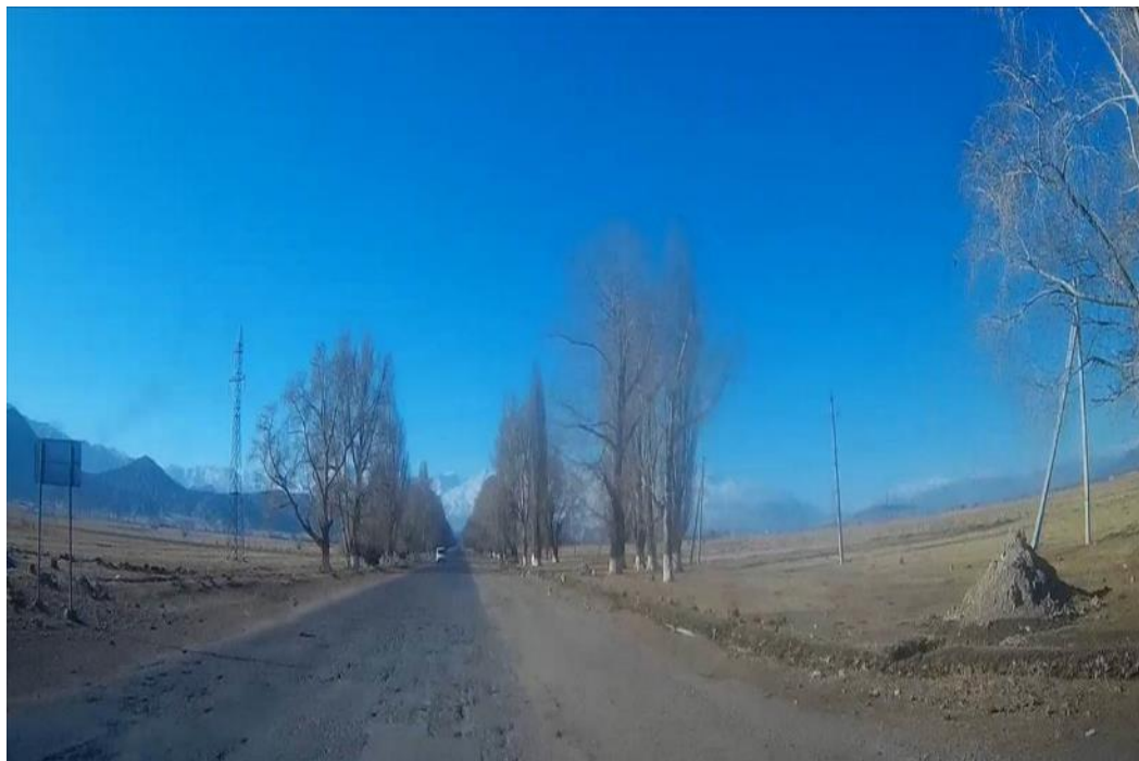
Фото 16. Начало участка дороги Тендик-Кольцо.
