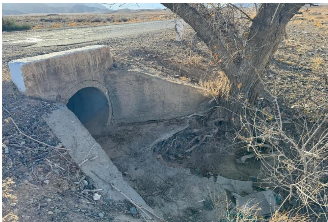
Фото 8. Состояние оголовков/открылок водоотводных сооружений на выходе.
