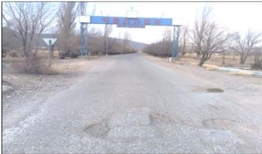
Фото 42. Начало подъездной дороги от трассы Кочкор-Эпкин (ПК 81+400) к селу Чолпон
