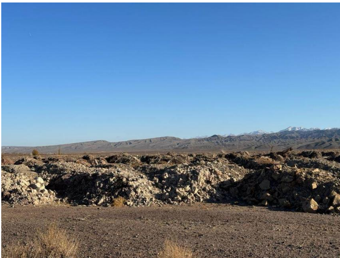
Фото 12. Отвалы строительного мусора, непригодного грунта
