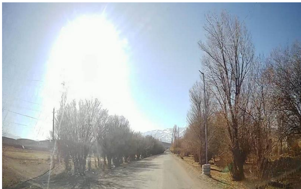
Фото 43. Конец участка подъездной дороги от трассы Кочкор-Эпкин (ПК 81+400) к с. Чолпон
